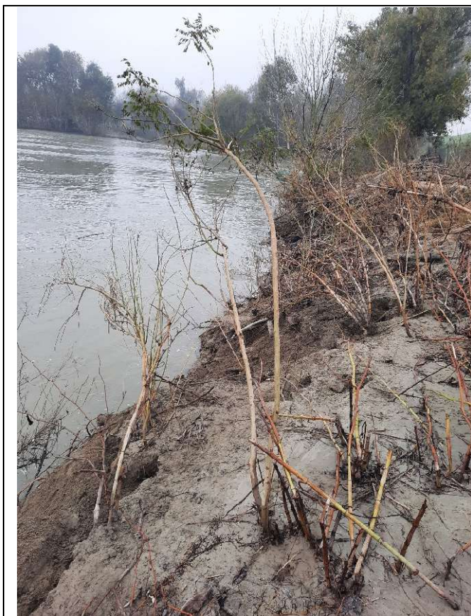
Frolo di Bergantino st. 45-47 – particolare del fenomeno erosivo sulla difesa di sponda
